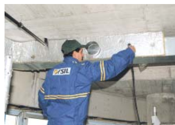
Mechanické kotvenie izolácie k potrubiu pomocou navarovacích TS svorníkov
