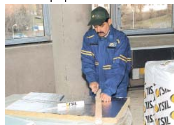
Rezanie izolácie nožom podľa rozmerov potrubia
