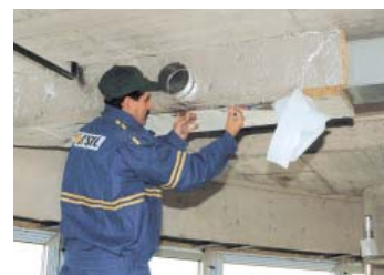
Prelepenie vodorovných a zvislých stykov izolácie hliníkovou páskou
